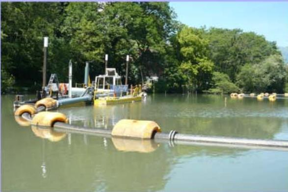
Der Saugbagger 'Pollux' saugt schwimmend auf dem Seegrund die Sedimente ab. Der Schlamm wird über 250m Druckleitungen, die mit Schwimmkörpern versehen sind, an Land befördert.
