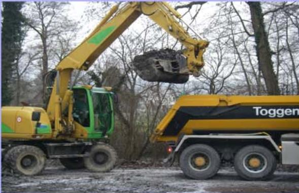
Nach der Konsolidierungsphase werden die Tencate Geotube® aufgeschnitten und der entwässerte Inhalt ausgebaggert, auf den Lkw aufgeladen und zur Deponie gefahren.
