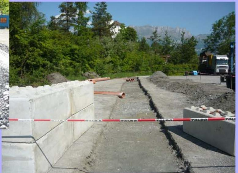
ca.450m Gräben ausgehoben und feste Rohre für die Rückleitung in den See verlegt
